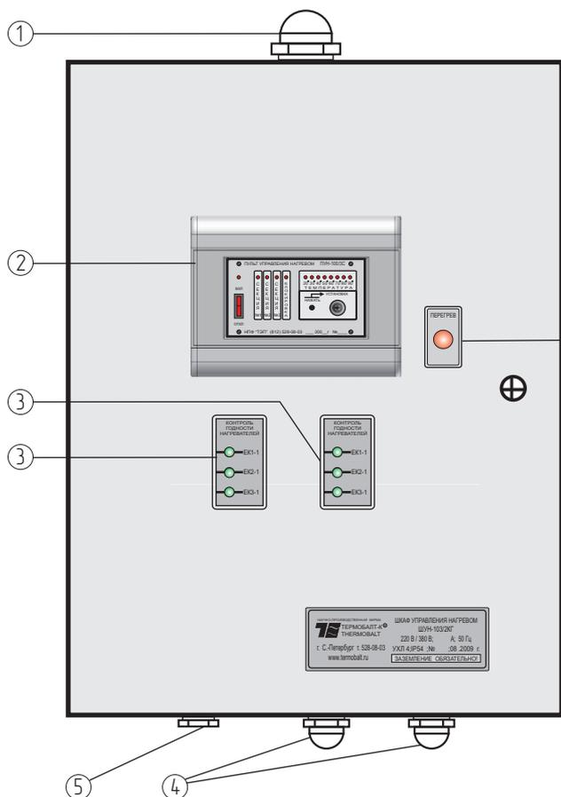
1. Сальник ввода силового кабеля Pg 29 (Pg 36). Диаметр кабеля 18–25 (22–32) мм.
